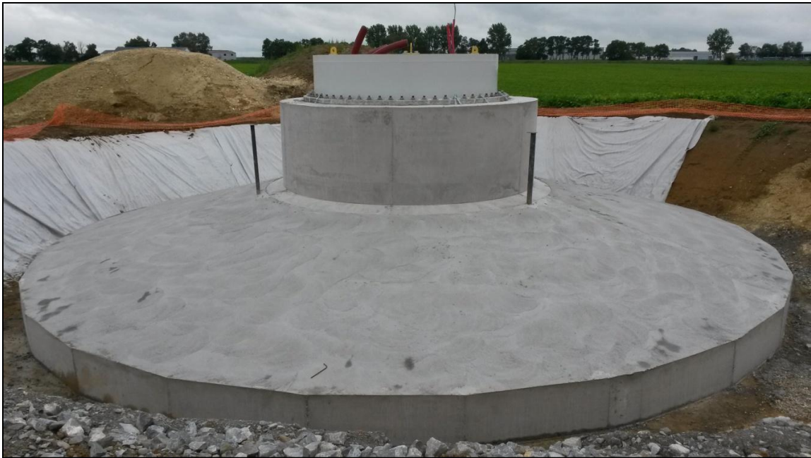
Figure 3 : fondation d'une éolienne, parc éolien de l'ouest royen (80)
